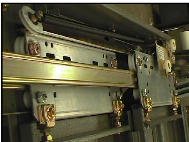
**10.** С целью продления термина эксплуатации роликов каретки, проводите периодическую чистку верхней лыжи дверей. Нанесение каких-либо смазочных материалов на лыжу настоятельно не рекомендуется.
